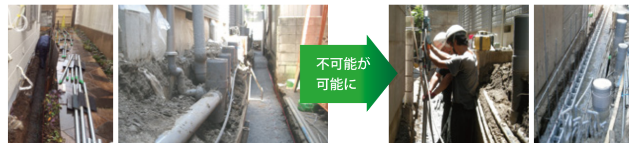
在来工法では擁壁築造が不可能な現場は多くあります
