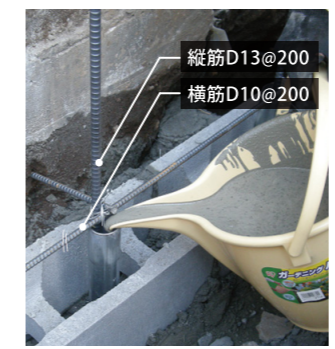
型枠CB内挿入鉄筋
