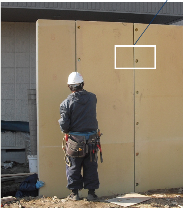
ユニットパネル建込み
