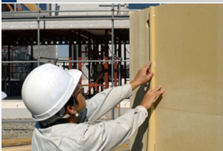
03 連結部パッキン施工
