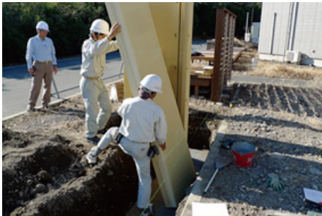
01 ユニットパネル建込み
