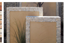
ジョリバットコテ塗り +モザイクタイル仕上げ
