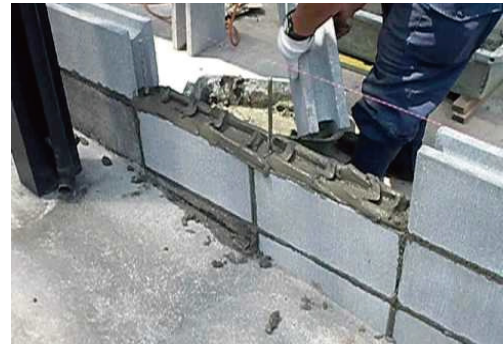
ブロック塀 建込み
