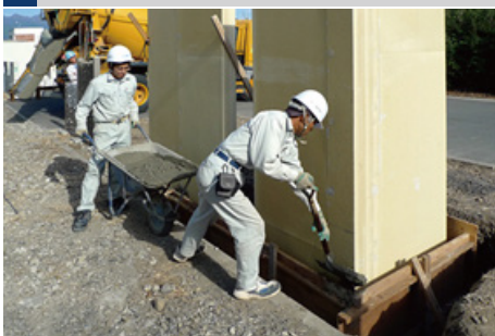
04 根巻きコンクリート
