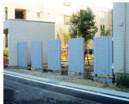
ALC Block assembly ALC建て込み
