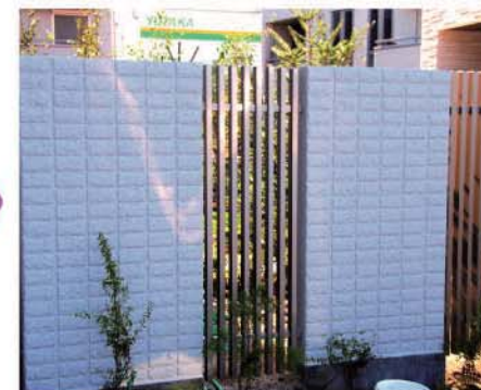
Installation of aluminum fence アルミフェンスの取付け
